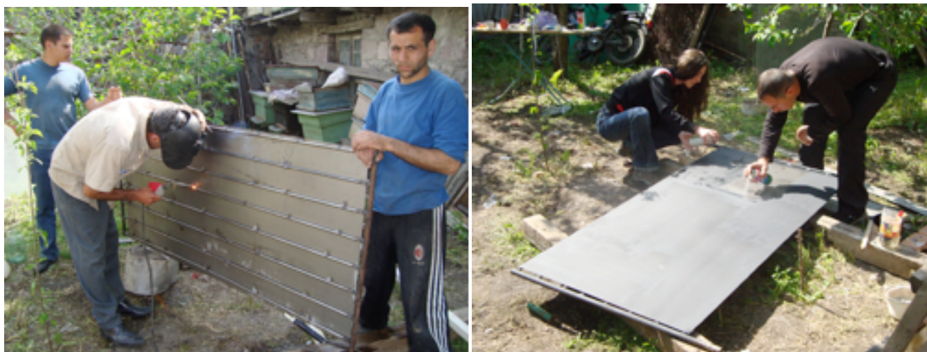
сборка и покраска плоского металлического коллектора
