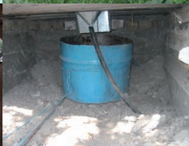
Однокамерный сухой туалет: фекалии собираются в голубую цистерну на колёсах
