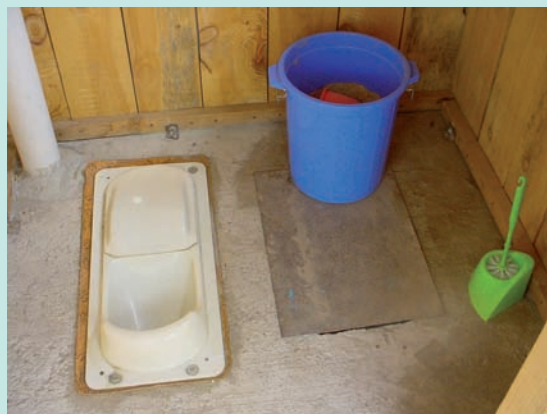
Внутри сухого туалета: сиденье сделано в Китае. Ведро заполнено опилками для "смывки"
