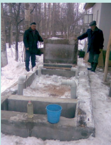
Фильтр с растительным покровом в Жетигене. Фильтр ни разу не замерз даже при температуре -20С
