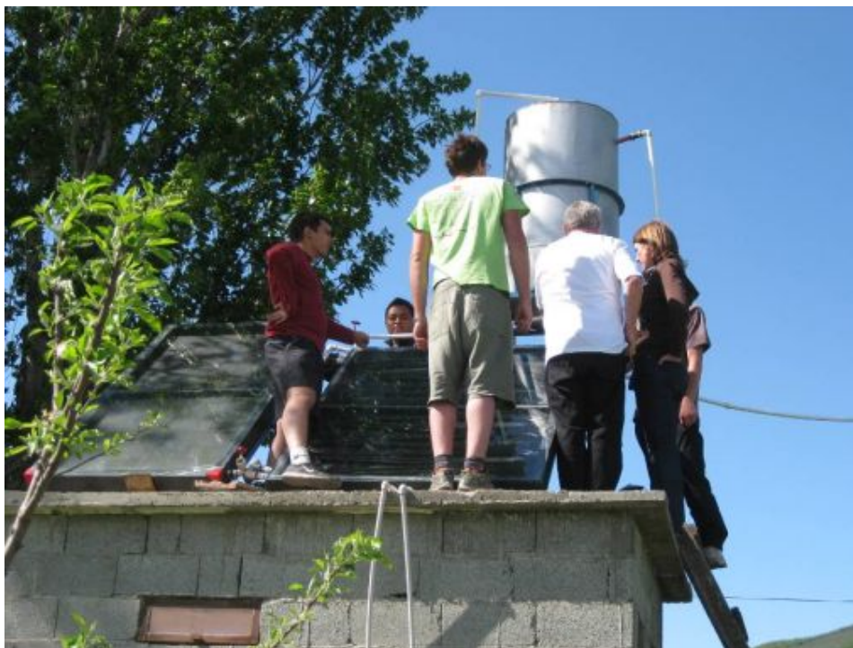
Installation of 2 panneaux (fer, plastique) sur le toit du bâtiment pour les toilettes et les douches Ecosan de RCDA
