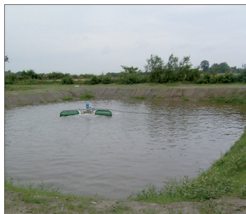
Аерационен басейн 3, аератор на повърхността
