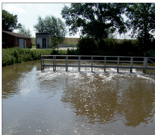
Аерационен басейн 1 на фона на сграда за експлоатационно обслужване (отляво) и сграда, в която се намира филтриращо съоръжение
