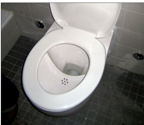
Тоалетна с разделяне и отмиване на урината
