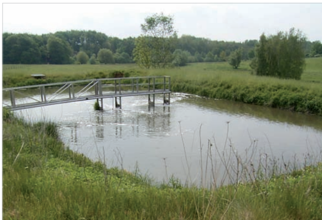
Bazin de aerare Schlamerdorf, Germania
