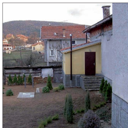
Clădirea toaletei și epurarea apei gri în zona umedă construită
