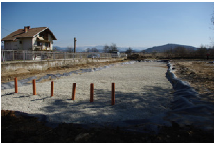
Завършената изкуствена влажна зона с вентилационни тръби отпред
