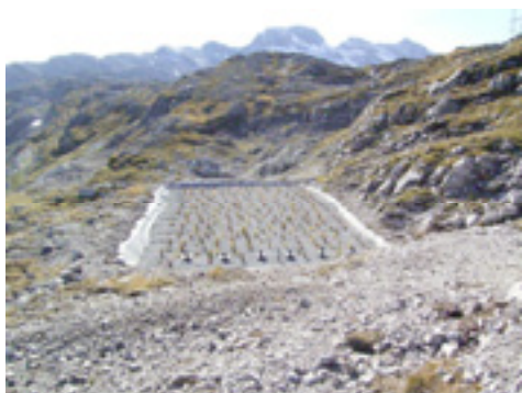
Изкуствена влажна зона за пречистване на сивата вода във Воралбер, Австрия
