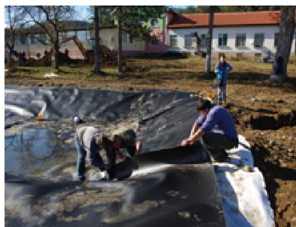
Заварка на изолационния слой
