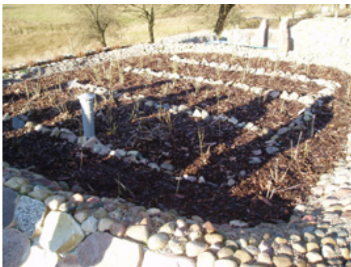
Изкуствена влажна зона за пречистване на битова отпадъчна вода в Полша
