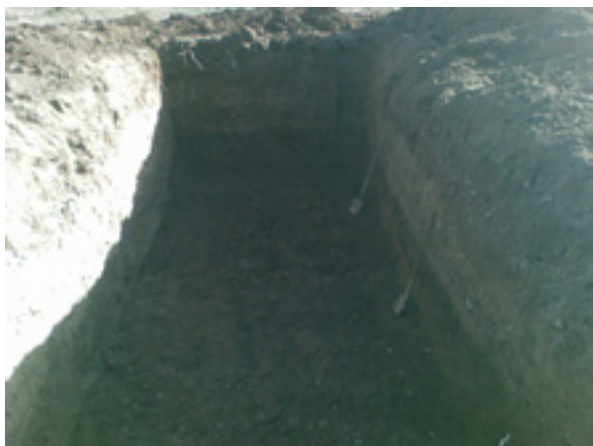
Изкопаване на събирателния резервоар
