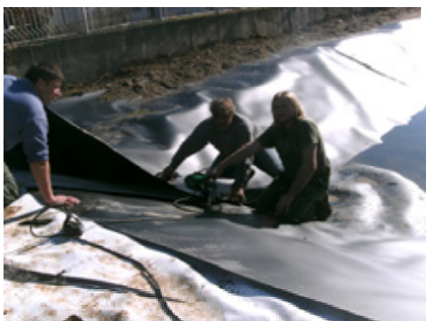
Заварка на изолационния слой
