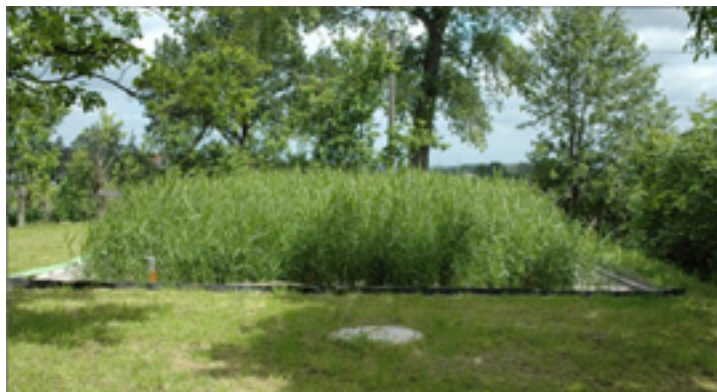
Изкуствена влажна зона за общински отпадъчни води в Йорлингхаузен, Германия
