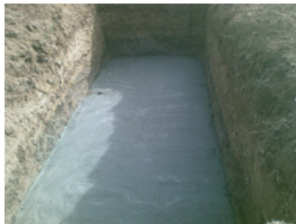
Изкопаване на събирателния колектор с изравнителен слой
