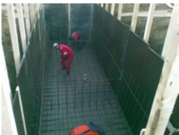
Подсилване на бетона (събирателни колектори)
