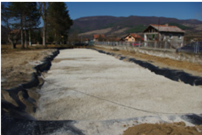
Изкуствената влажна зона в завършен вид, без растения
