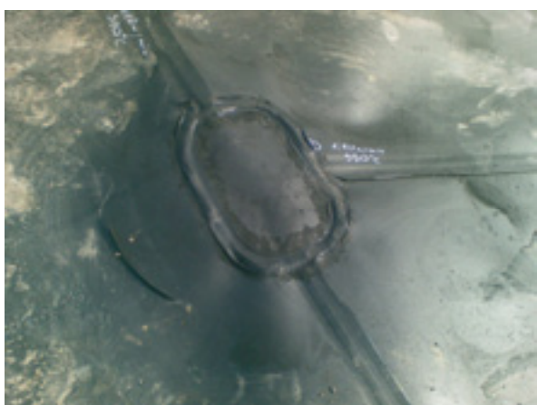
Заварка на изолационния слой
