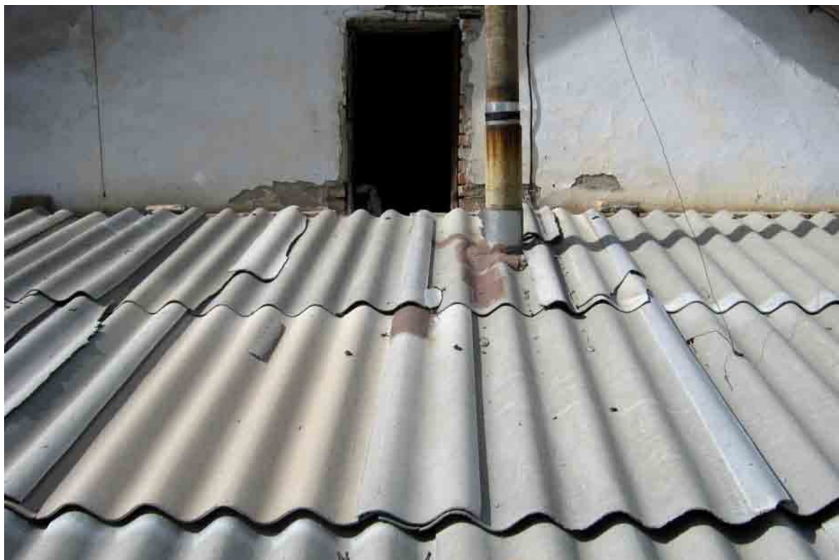
Шиферная кровля, г. Бишкек
