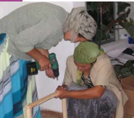
Кыргызские женщины монтируют солнечный водонагреватель. БИОМ, партнёр WECF в Кыргызстане
