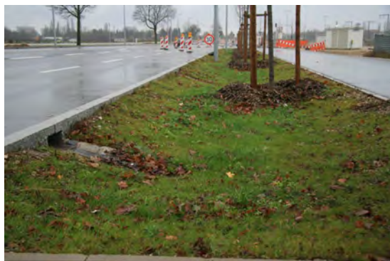
Different swale infiltration systems Photo's: Münchener Stadtentwässerung
