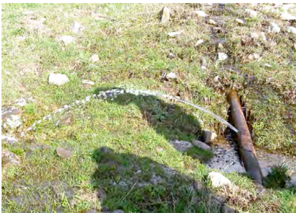
Корозија може да предизвика сериозни истекнувања во дистрибутивниот систем
