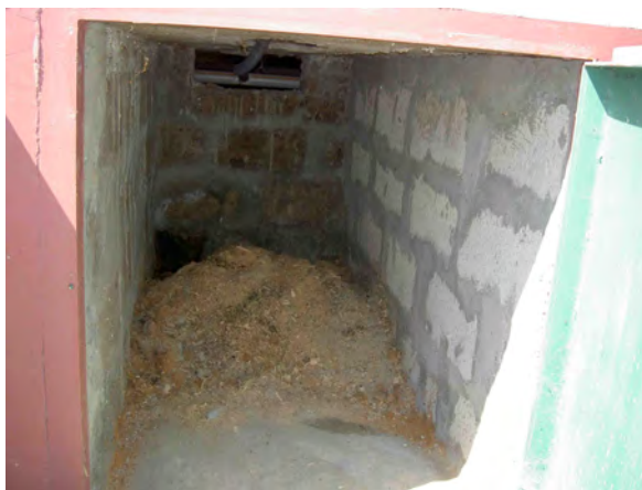
Училишен СТПУ: комора за собирање, складирање и третман на фекални материји
