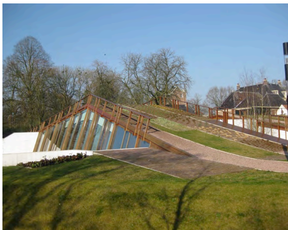
Пример на екстензивен зелен покрив на зграда од јавен интерес
