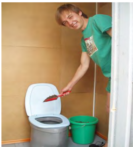
Плакнење на тоалет по употреба кај сув тоалет за пренасочување на урината во Украина
