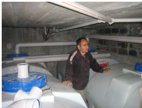
Училишен СТПУ: сутерен со резервоари за собирање, складирање и третман на урина од 350 користења
