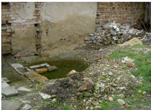
Апсорбирачка јама полна со отпадни води
