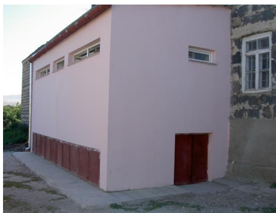
Exterior al unei toalete cu sistem de separare a urinei, atașat de clădirea școlii
