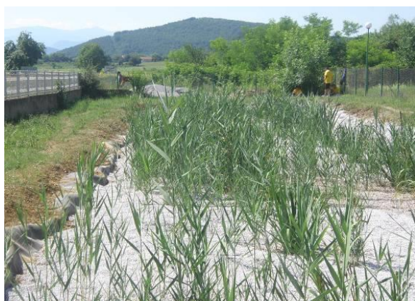
Filtru de sol cu trestie plantată în Vidrare, Bulgaria
