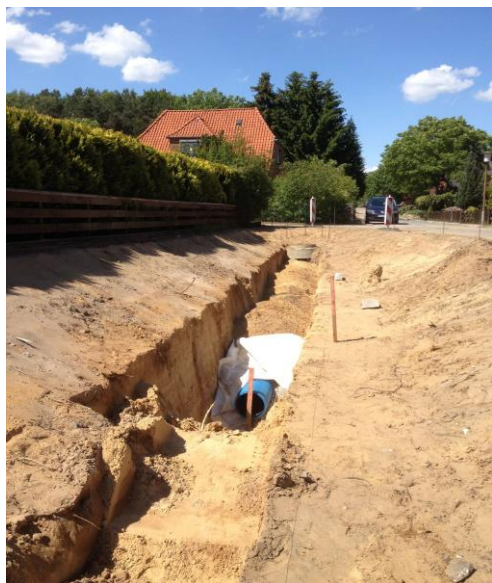
Sistem de infiltrație prin rigole – în construcție Sursă foto: Arnd Wendland
