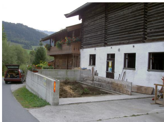
Bălegarul trebuie stocat pe platforme cimentate, împrejmuite
