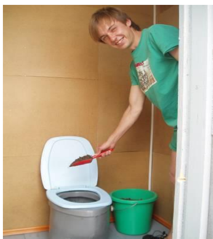
Spălarea toaletei după utilizare, în cazul unei toalete uscate cu sistem de separare a urinei, în Ucraina
