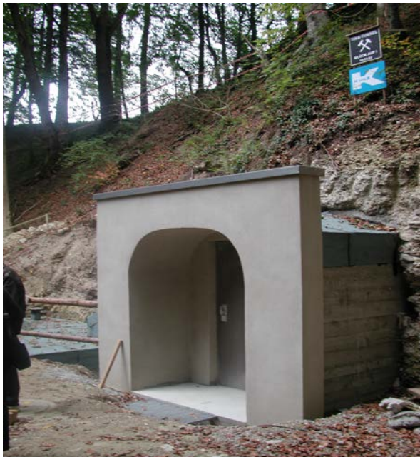
Entrance of a spring catchment Photo source: Bayerisches Landesamt für Umwelt (Bavarian State office for Environment); http://www.lfu.bayern.de/wasser/merkblattsammlung/teil2_gewaesserkundlicher_dienst/doc/nr_219_anlage6.pdf
