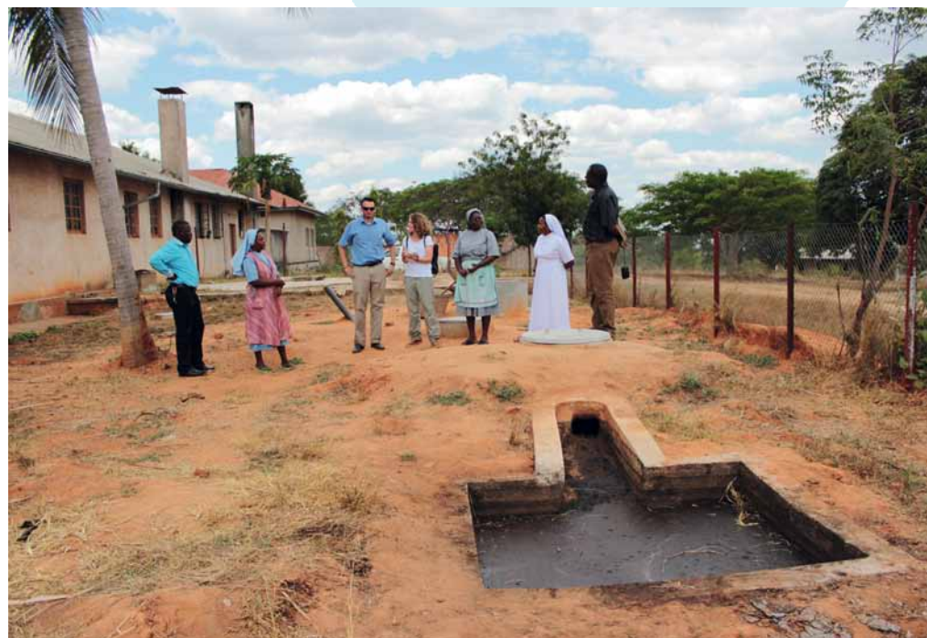
Blick auf den Auslauf der Biogasanlage mit 13 m 3 Füllvolumen bei der Mission Lupaso im Masasi Distrikt
