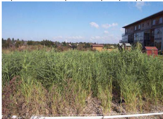
Zonă umedă construită, în Germania
