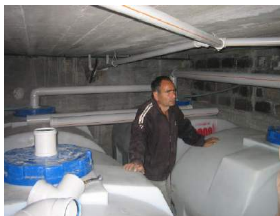
Toaletă cu sistem de separare a urinei în școală: subsol cu rezervoare pentru colectarea, depozitarea și epurarea urinei pentru 350 de utilizări
