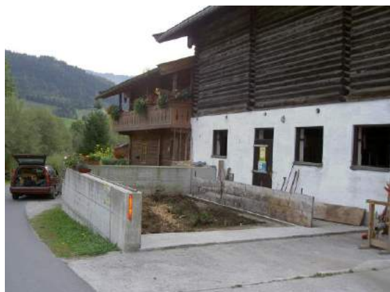
Bălegarul trebuie stocat pe platforme cimentate, împrejmuite.
