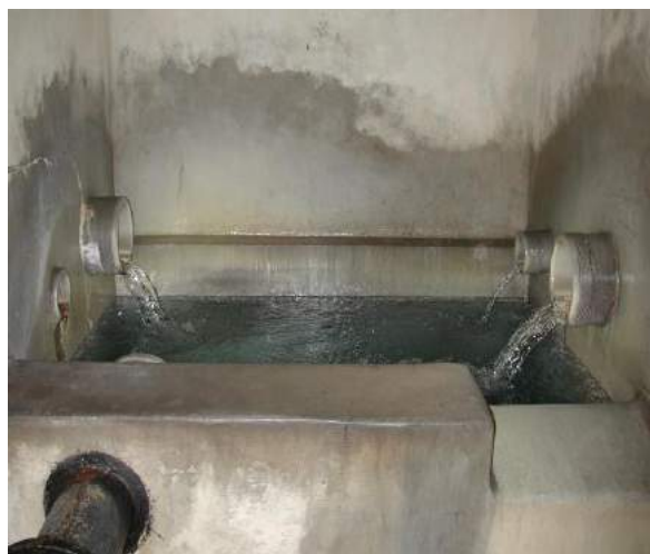
Captarea unui izvor în Bavaria. Captarea apei izvoarelor poate fi făcută cu mai multe conducte de drenaj. Bazinul trebuie acoperit și izolat.
