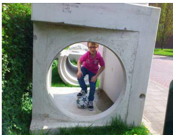
Conductă de canal inclusiv cămin de vizitare care va fi plasat subteran
