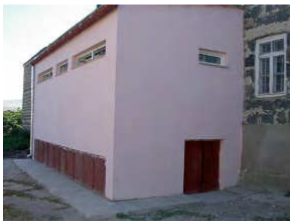
Надворешен изглед на објект за UDDT залепен за училишна зграда
