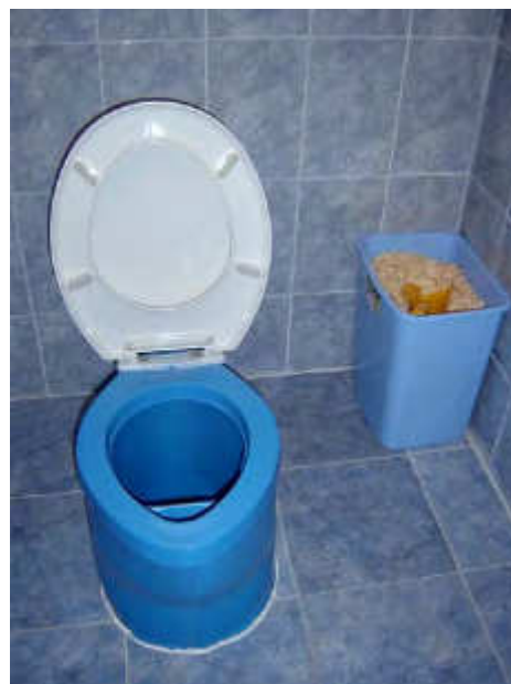
Внатрешност на Ecosan тоалет, (UDDT), изграден во куќа во Бугарија. Слика: Earth Forever
