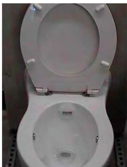
Вакуум тоалетите користат по еден литар на вода при исфрлање
