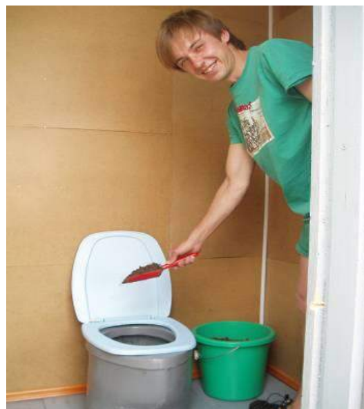
Spălarea toaletei după utilizare, în cazul unei toalete cu sistem de separare a urinei - toaletă uscată (UDDT) în Ucraina
