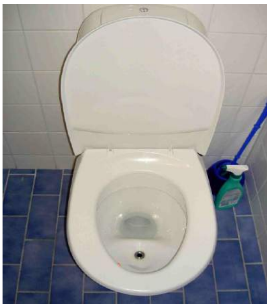
Toaletă cu sistem de separare a urinei, cu spălare
