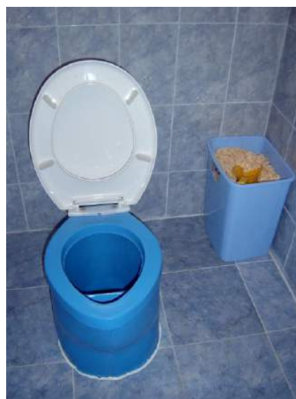
Fig. 4: Interiorul unei toalete Ecosan , Toaletă (UDDT), amplasată în interiorul unei case din Bulgaria. Foto: Earth Forever
