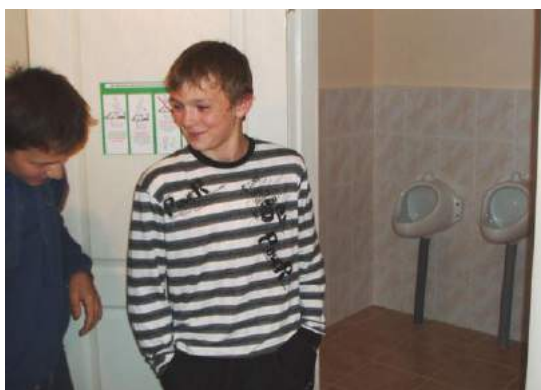
Pisoare fără apă, de diferite înălțimi
