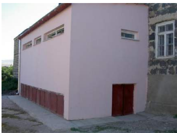
Exteriorul unei instalații UDDT anexată unei școli
