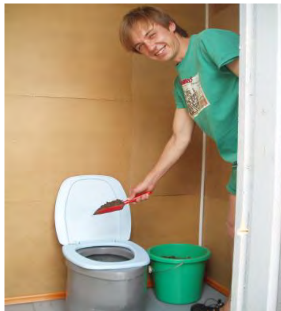
“Изплакване” на тоалетната след използване при суха тоалетна с разделяне на урината (UDDT) в Украйна
