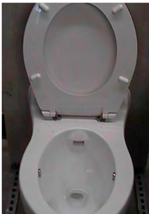
Вакуумна тоалетна, която използва само един литър вода на изплакване
