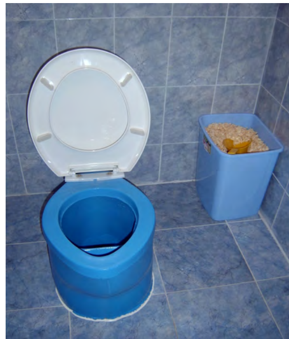
Вътрешност на Ecosan тоалетна (UDDT) кабинка, конструирана в къща в България. Снимка: Earth Forever
